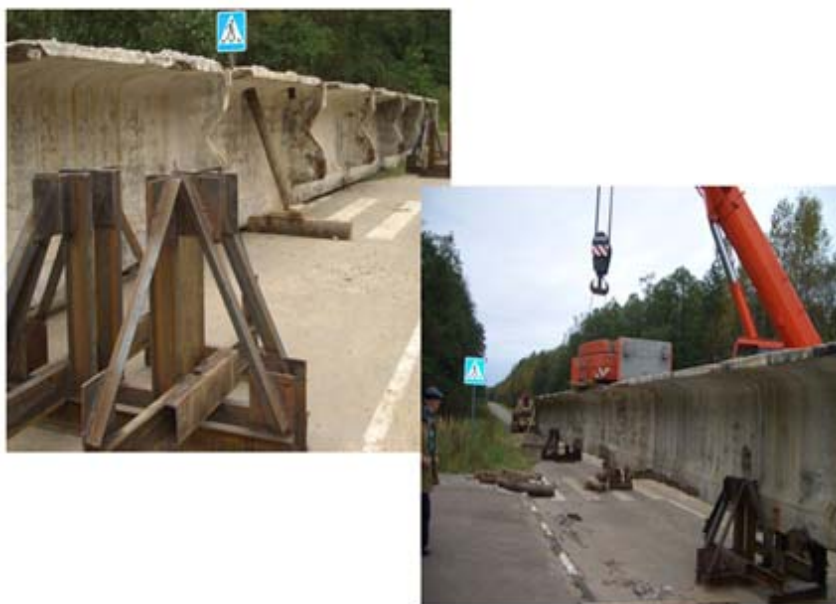
Рис. 4. Испытание до разрушения железобетонной балки l = 33 м, срок эксплуатации балки 42 года. Снижение несущей способности – 45%
