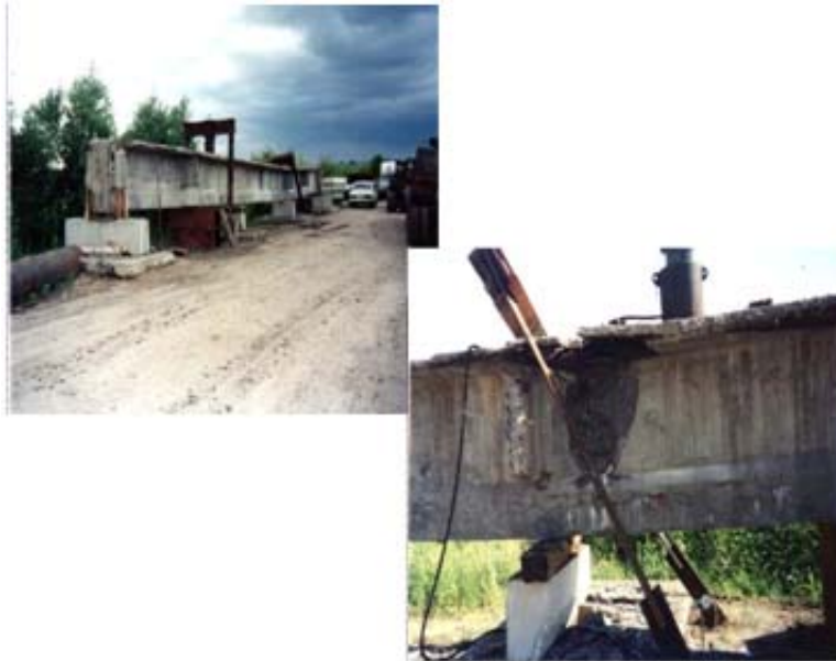
Рис. 3. Испытания до разрушения железобетонной балки l = 23,4 м, срок эксплуатации 40 лет. Снижение несущей способности – 50%
