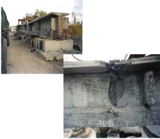
Рис. 2. Испытания до разрушения железобетонной балки l = 22,16 м, срок эксплуатации 36 лет. Снижение несущей способности – 30%
