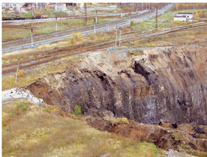
Авария в Березняках на руднике компании «Уралкалий» произошла в октябре 2006 года. В результате аномального геологического строения пород в шахту хлынули соленые минерализованные воды. Возникла обширная зона проседания грунта. В опасной близости от нее оказались 29 жилых домов, школа, 2 детских сада и линия железной дороги
