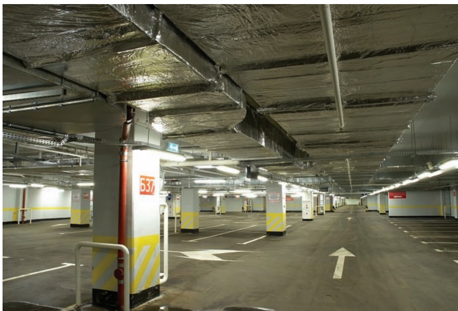
Рис. 3. Огнезащита воздуховодов паркинга с использованием покрытия Изовент
