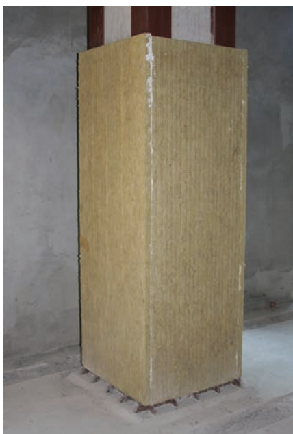
Рис. 2. Внешний вид металлоконструкции с огнезащитным покрытием Изовент-П (R 90- R 150)
