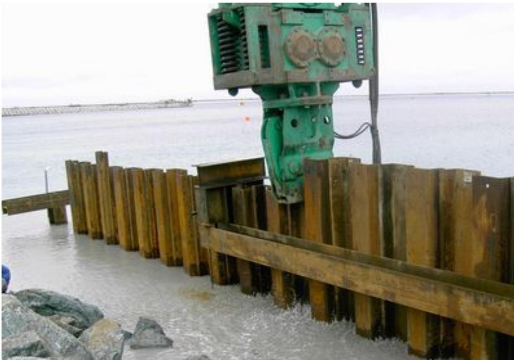
Рис. 1. Погружение шпунта вибропогружателем
