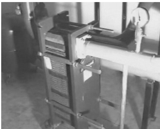
Рис. 6.5. Пластинчатый водоподогреватель в сборе
